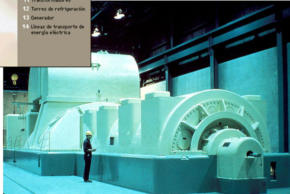
*Imagen de un turboalternador en una central térmica para producción de energía eléctrica*
