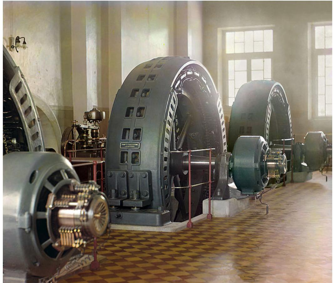
*Alternadores de polos salientes en una central hidroeléctrica para producción de energía eléctrica*
